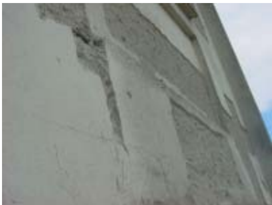
Foto 1: Reparo em fachadas com fissuras isoladas.
