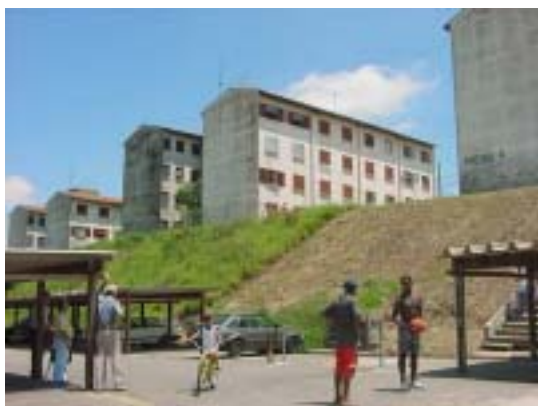
Foto 3: Fachadas dos prédios antes da recuperação.
