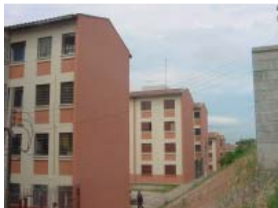
Foto 4: Fachadas dos prédios após a recuperação.
