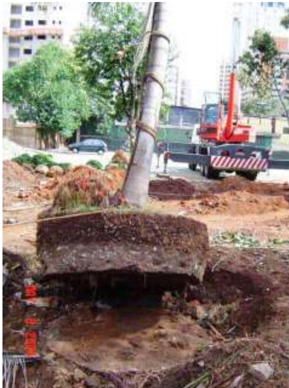
Foto 11 - Parte do sub-solo impermeabilizado. Fonte: o autor.
