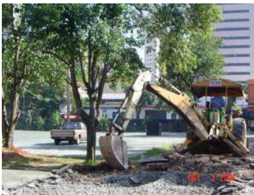
Foto 5 - Utilização de retro-escavadeira para preparação de torrão. Fonte: o autor.
