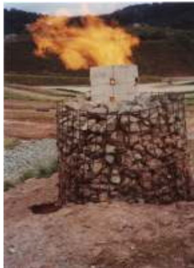
Figura 5: Sistema tradicional de disposição de metano aterros Fonte: Biogás Energia Ambiental (2008)
