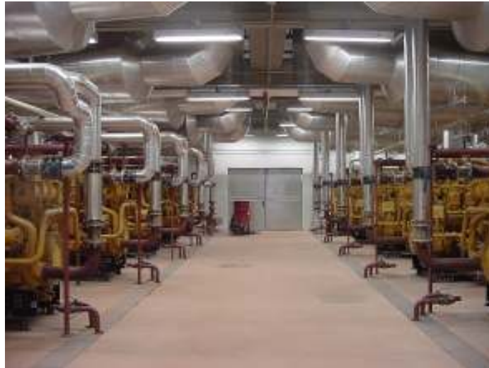
Figura 12: Moto-gerador da Usina Fonte: Acervo Itaú Unibanco (2007)
