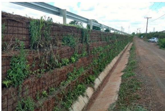
Foto 2. Muro de contenção implantado (nov/2019).
