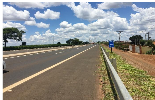
Foto 3. Pavimento da pista duplicada (nov/2019).
