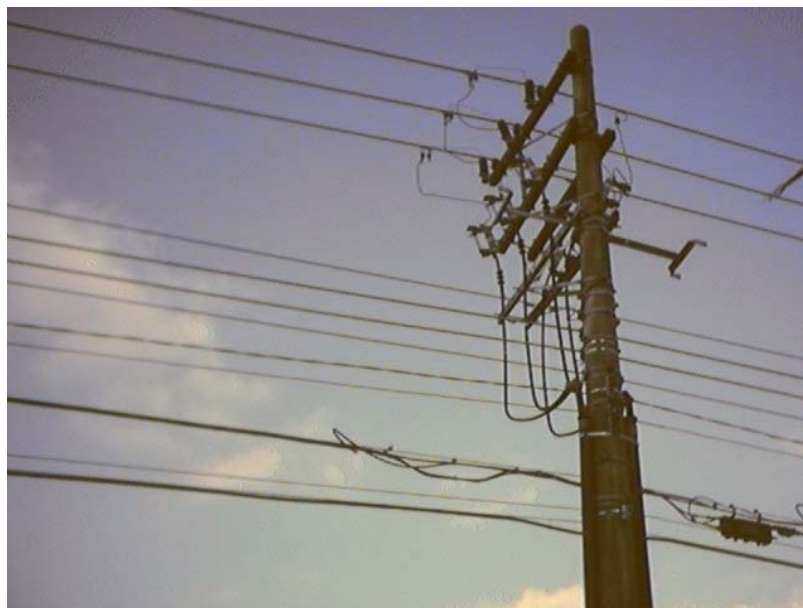
Figura 2.7 – Exemplo de linha de distribuição primária e secundária
