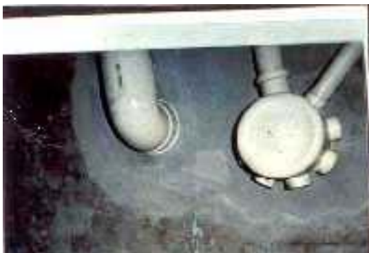
Foto 8 - Grauteamento da tubulação com a laje
