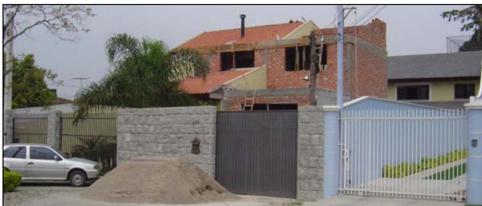
Foto 3 – Exemplo de residência isolada em reforma
