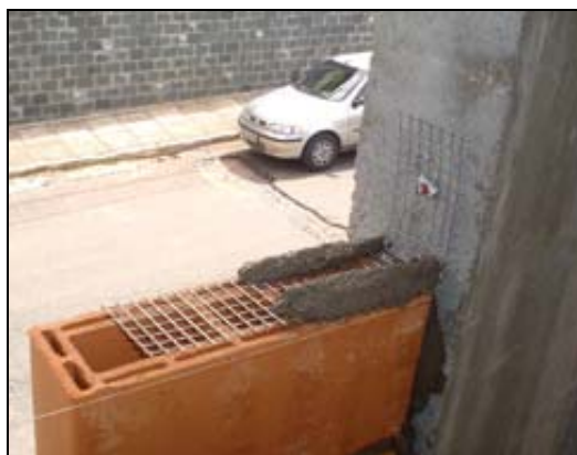
Foto 5 - Utilização de telas metálicas na ligação parede/pilar
