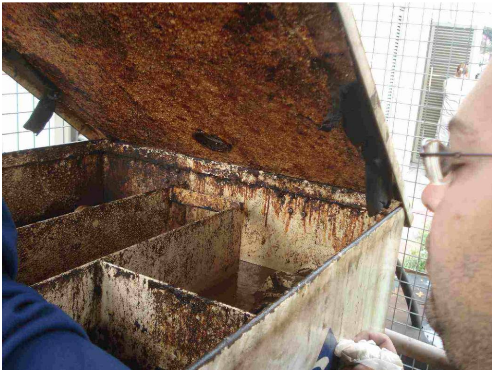
Figura 5.5 Exposição aos contaminantes durante a limpeza de caixas separadoras
