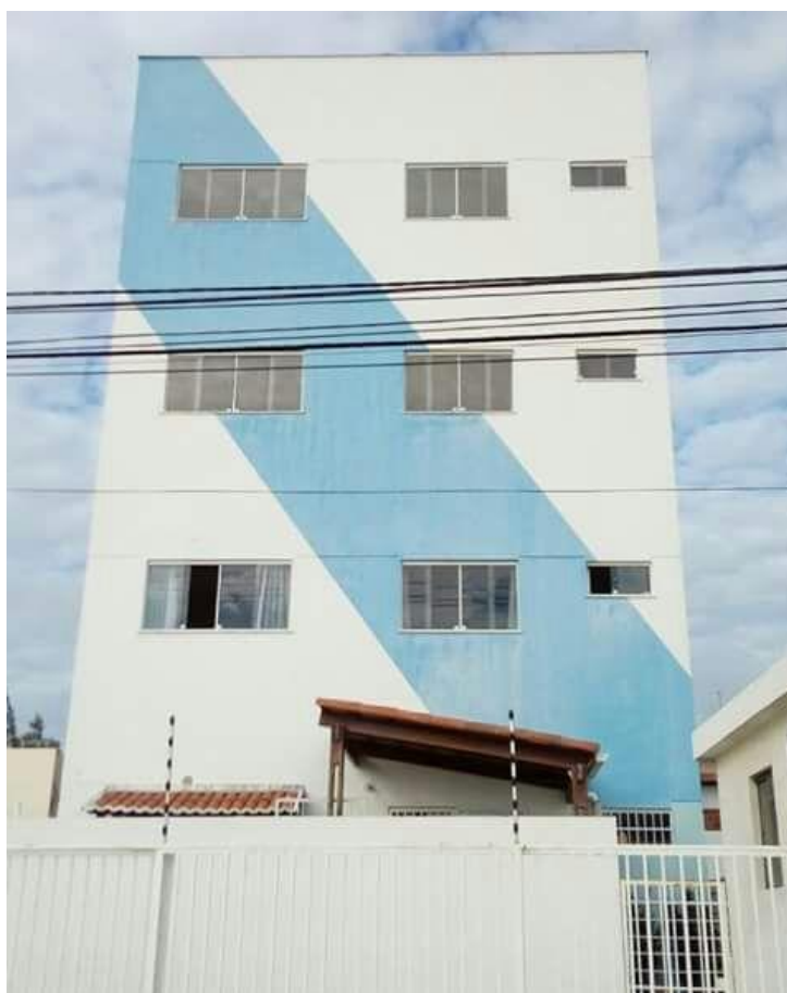
Figura 4: Edificação conforme padrões da ABNT
